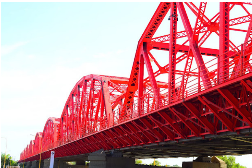
Foto 75a : Así quedó el Puente Carretero después de los trabajos de re funcionalización
