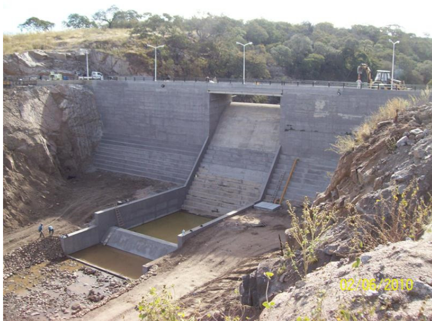
Foto 78: Construcción del Dique de Villa la Punta.
