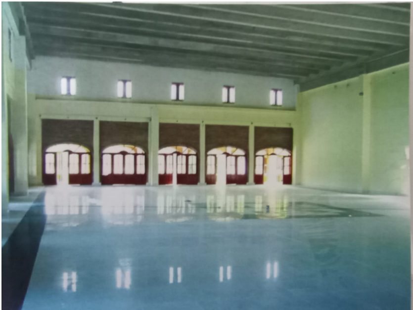
Foto 98: Se puede observar el piso terminado y el techo sin cielorraso.
