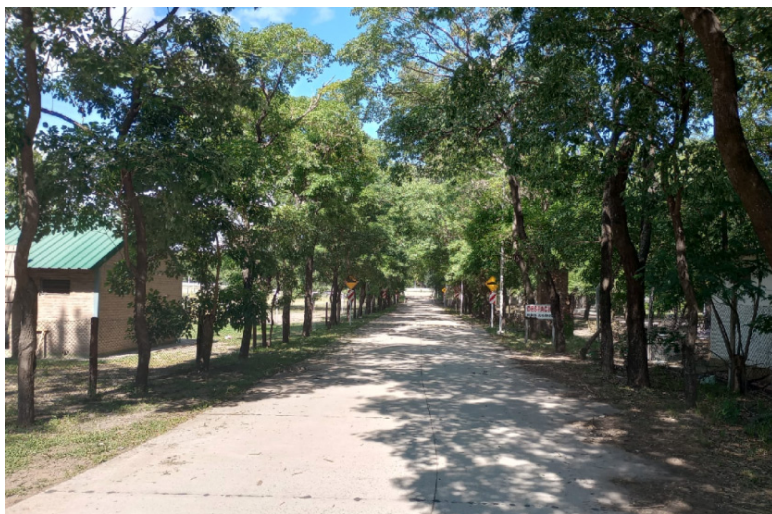
Foto 114: Nuevo ingreso pavimentado
