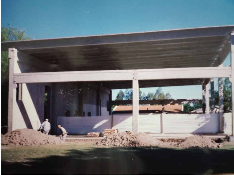
Foto 58: Inicio del Cerramiento del Salón.
