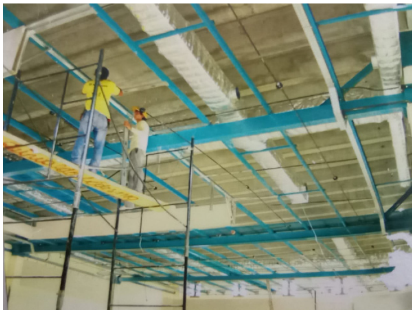
Foto 99: Construcción del cielorraso y climatización
