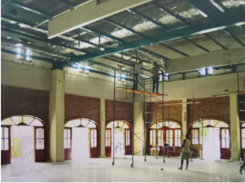
Foto 100: Construcción del cielorraso y climatización
